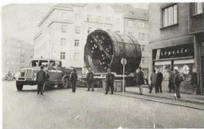
Рис. 2. Перевозка щита на трейлере
