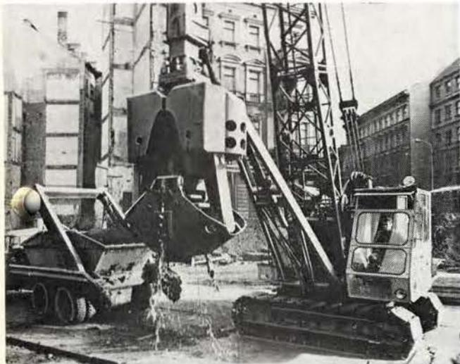
На строительстве ст. «Соколовская». Разработка траншеи для устройства железобетонной стены в грунте
