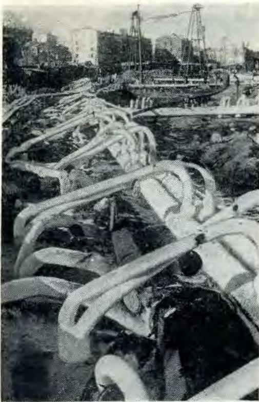
Рис. 3. Замораживание грунта на одном из участков перегона между станциями «Барриадная» — «Площадь 1905 г.»
