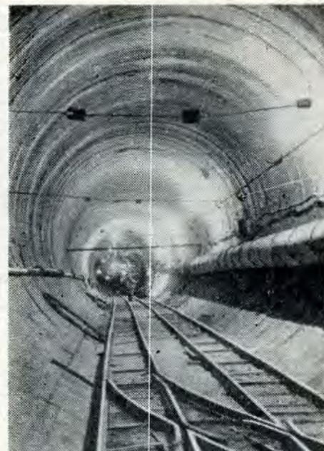
Рис. 3. Перегонный тоннель, сооруженный из пресс-бетона
