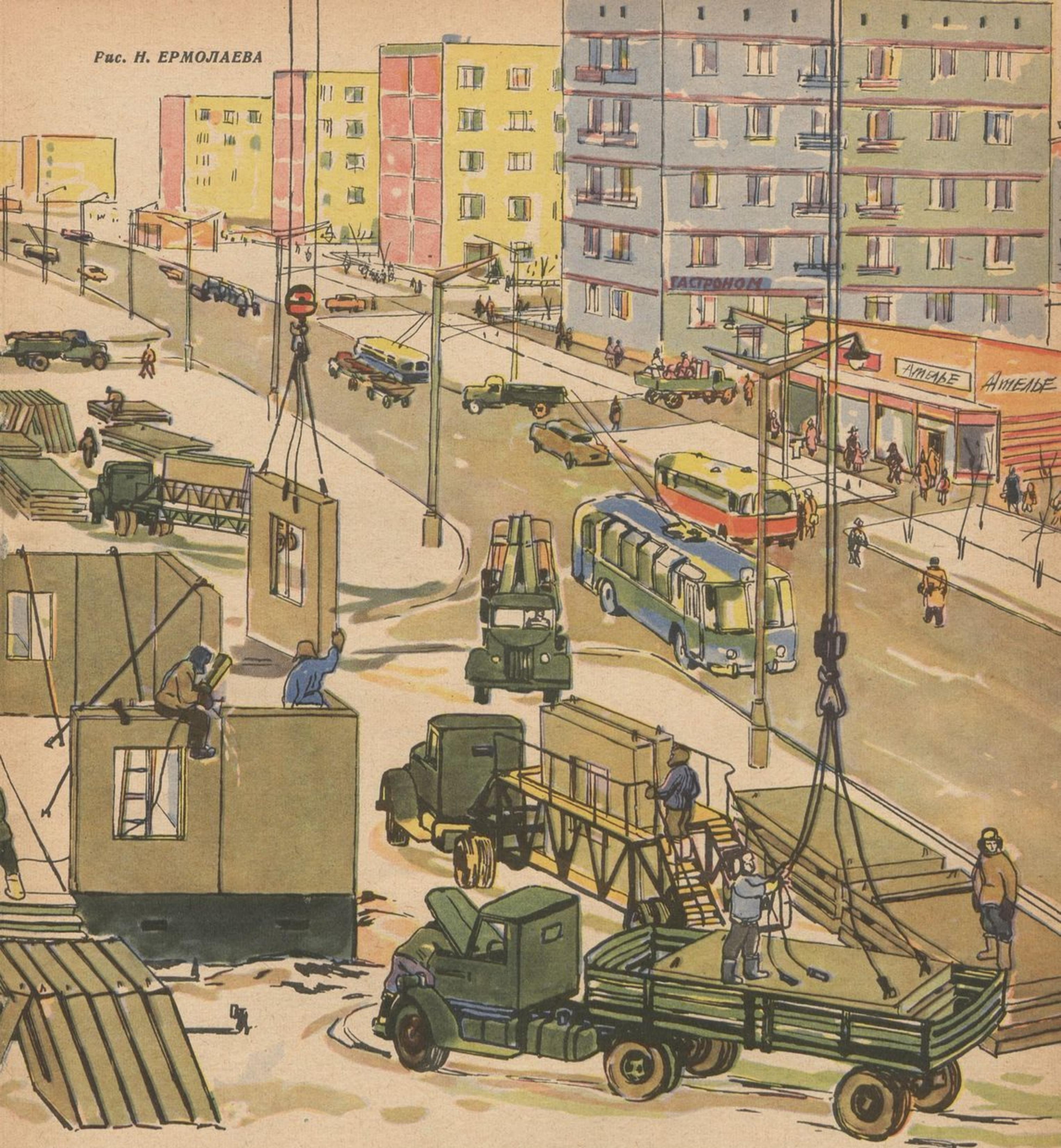
Привезут на строительную площадку, и сразу же монтажный кран их выгружает и ставит на место — в стену. Монтажники только укрепляют их, а сварщики сваривают панели одну с другой.
