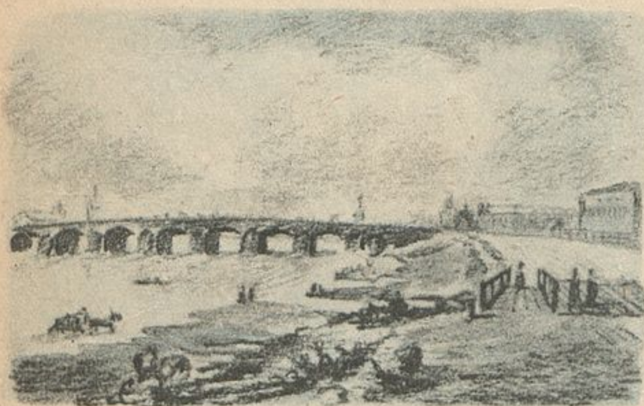
Каменный мост через Москва-реку сто пятьдесят лет назад.
