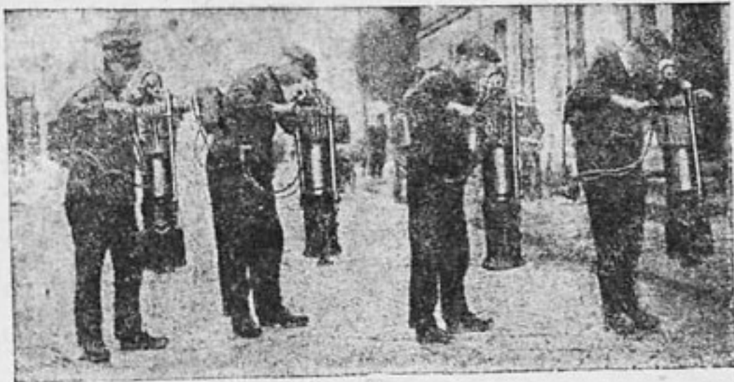
Новые трамбовки внутреннего сгорания в действии
