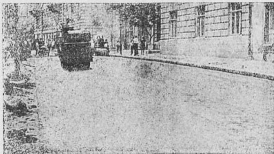
Дорожные работы в Москве. Снято в последних операциях Фото Н. Коноплева
