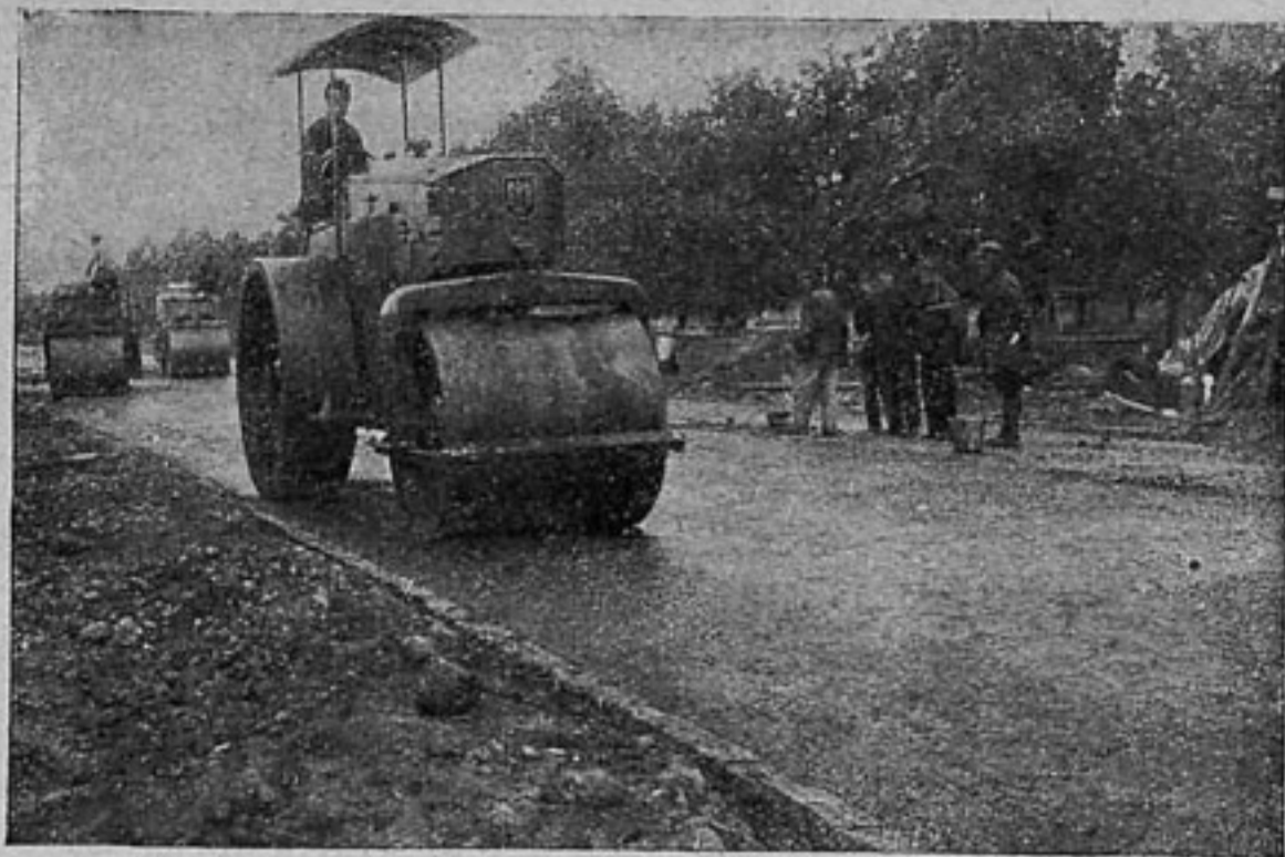
На дорожных работах
