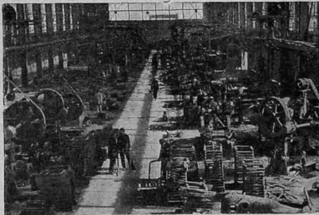
Сталинградский тракторный завод. В кузнечном цехе
